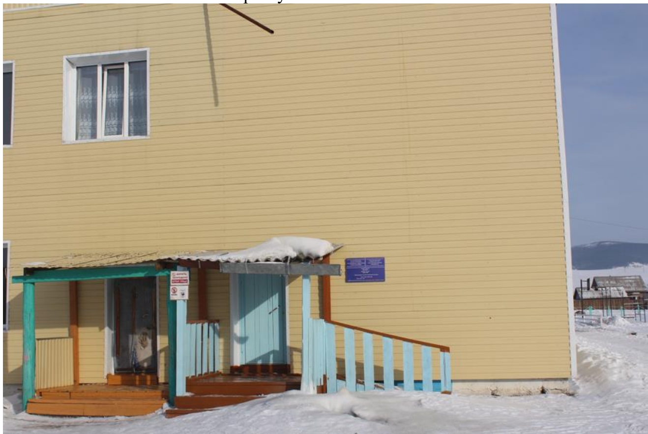
На фото: Нарсатуйский ФАП, капитальный ремонт проведен в 2010 году
